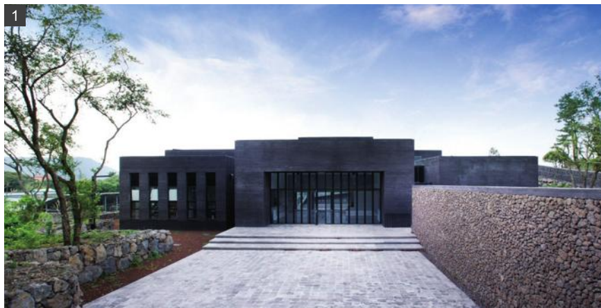
1 물방울 화가 김창열미술관 전경. 제주 상징인 현무암을 따라 검은 외관을 차용했다.
